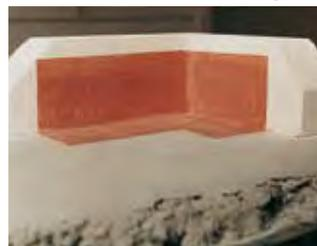
Durchbrüche und andere Anschlüsse müssen in gleicher Weise wasserbeständig abgedichtet werden.
