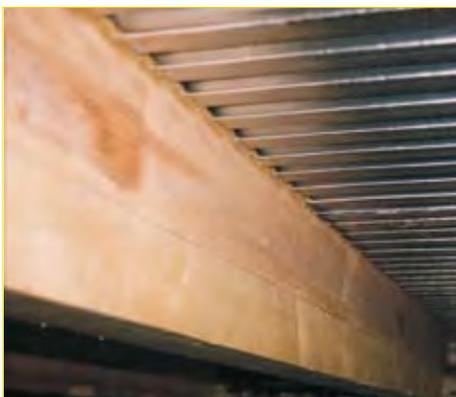
In Deutschland (Universität Kaiserslautern Fachrichtung Stahlbau) und in den Niederlanden (TNO Bouw) wurden Tragfähigkeits-Untersuchungen mit LEWIS®-Platten auf Holzbalkenlagen vorgenommen. Diese Untersuchungen wurden durchgeführt für vernagelten und schwimmenden Aufbau.
