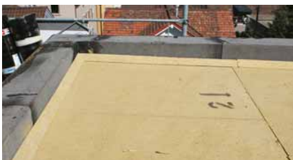
Dachrandkeile bei Aufbordungen im Flachdach.
