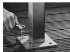
Pfosten ausrichten und montieren.
