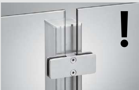
Montage Glas mit Klemmbacken Die Scheiben werden von außen (Nachbarseite) an die Pfosten befestigt
