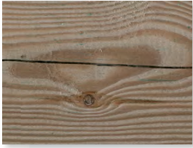
Spannungsrisse durch die Holz-trocknung
