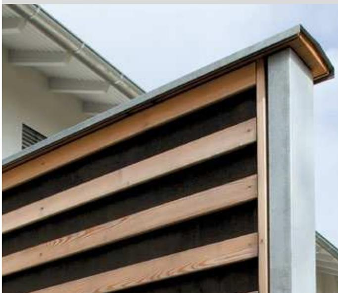
Ausführung mit Stahlpfosten
